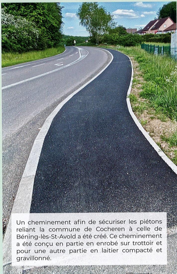
Un cheminement afin de sécuriser les piétons reliant la commune de Cocheren à celle de Béning-lès-St-Avold a été créé. Ce cheminement a été conçu en partie en enrobé sur trottoir et pour une autre partie en laitier compacté et gravillonné.
